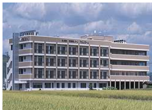
特別養護老人ホーム アダムスホーム (岡山県岡山市)
