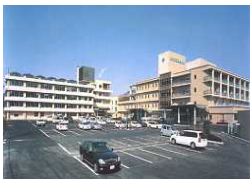
世羅中央病院組合 世羅中央病院 (広島県世羅郡)
